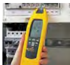
Localización de fusibles y disyuntores y asignación a los circuitos correspondientes
